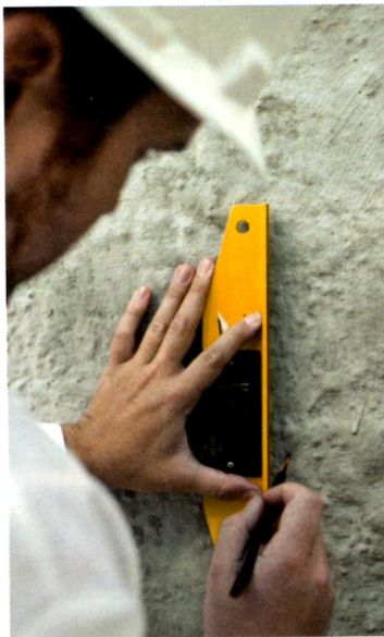
Figura 5 – Marcação de níveis e cotas de avanço
