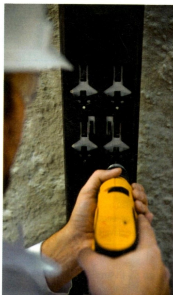
Figura 8 – Fixação dos perfis tipo rail
