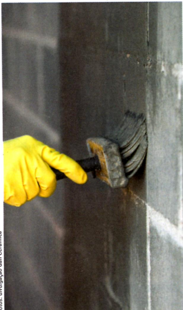
Figura 4 – Preparação da superfície
