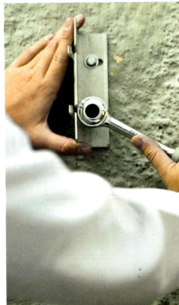
Figura 6 – Furação e Ancoragem
