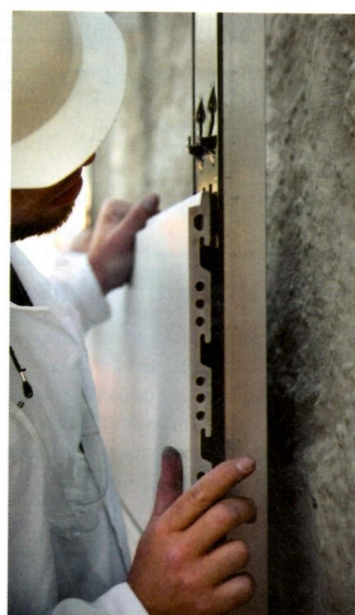
Figura 9 – Encaixe dos painéis cerâmicos
