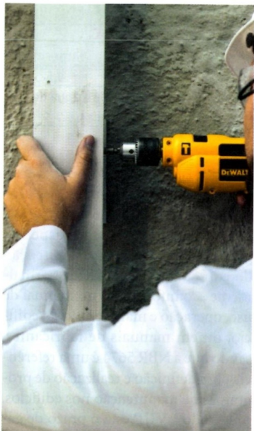
Figura 7 – Fixação dos perfis verticais
