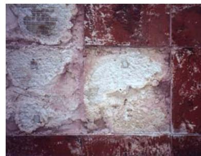
Descolamento do porcelanato causado pela ruptura do emboço que apresentava resistência mecânica insuficiente e falhas na aplicação. Tipologias diferentes de placas (prensadas, extrudadas, esmaltadas ou não, formatos grandes e pequenos e com diferentes graus de movimentação higroscópica) exigem não somente argamassas colantes e de rejuntamento diferentes como também de emboços de substrato apropriados
