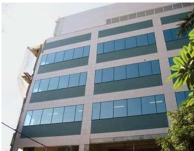
Aspecto da fachada de obra em São Paulo 100% revestida com porcelanato. Detalhe da modulação: placas maiores foram colocadas entre as juntas de movimentação horizontais e verticais
