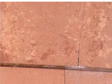
Ausência de reforço no emboço permitiu migração da fissura entre alvenaria e pilar para a camada externa, onde foi aplicado o porcelanato. O uso de telas metálicas especiais, membranas antifissura e juntas posicionadas corretamente poderia evitar o problema
