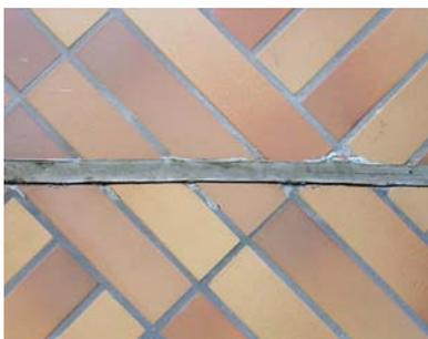
Falha no tratamento da junta de movimentação com selante pode implicar ocorrência de futura infiltração, sinal de seção transversal não retangular, ausência de limitador de profundidade (tarugo de espuma de polietileno) e falta de cuidado na limpeza da abertura. Para evitar o problema, é recomendável o frisamento do emboço fresco e o corte prévio das placas
