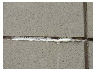
Boa parte dos casos de surgimento de eflorescência acontece devido à passagem da água por fissuras na interface entre rejunte e bordas da placa. Aderência à borda e capacidade de deformação são propriedades que devem ser exigidas da argamassa
