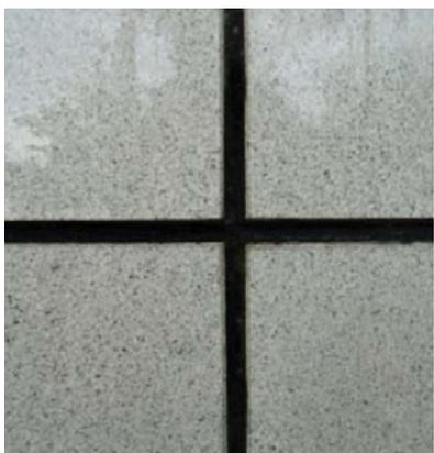
Presença de fungos e algas que se proliferaram na argamassa de rejunte, causados pelo uso de argamassa de rejunte com porosidade elevada e sem adição de agentes resistentes a esses microorganismos. Em pouco tempo, a fachada, mesmo se bem-executada, pode ficar com a estética comprometida, necessitando de manutenção periódica
