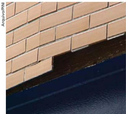
Descolamento de placas cerâmicas extrudadas não esmaltadas. Movimentação higroscópica exige compensação na resistência de aderência da argamassa colante, menor rigidez da argamassa de rejuntamento e compatibilidade do emboço de substrato. Mau espalhamento da argamassa colante, sem que seja cumprida a técnica de dupla colagem, contribui diretamente para o problema. Na ausência desses cuidados, mesmo com presença de juntas de movimentação, a manifestação costuma ocorrer
