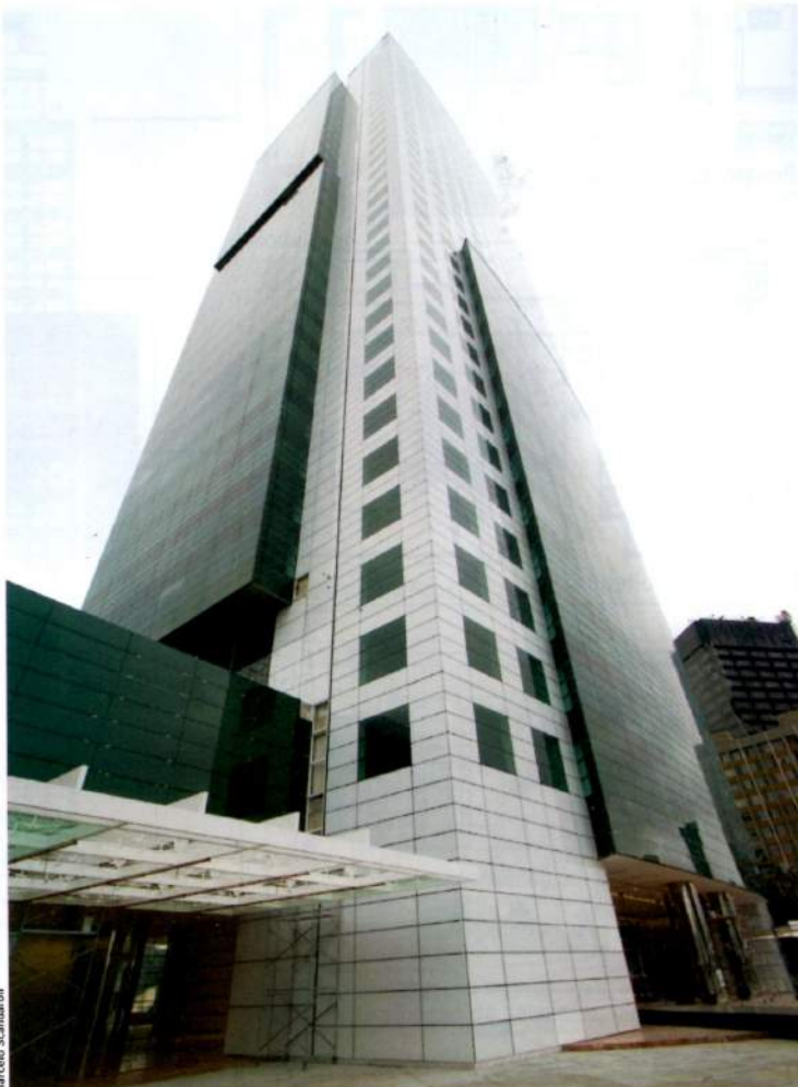
O sistema unitizado é o mais moderno atualmente. Nele, o painel já vem pronto, e geralmente tem a altura do piso a piso estrutural
